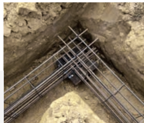
WYLEWANA ŻELBETOWA ŁAWA FUNDAMENTOWA
