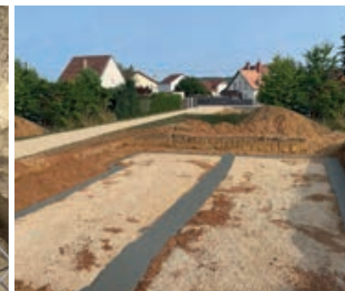
WYLEWANA ŻELBETOWA ŁAWA FUNDAMENTOWA
