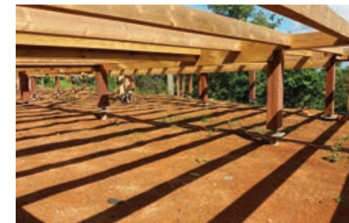
Konstrukcja ramy dla budynku w szkielecie drewnianym
