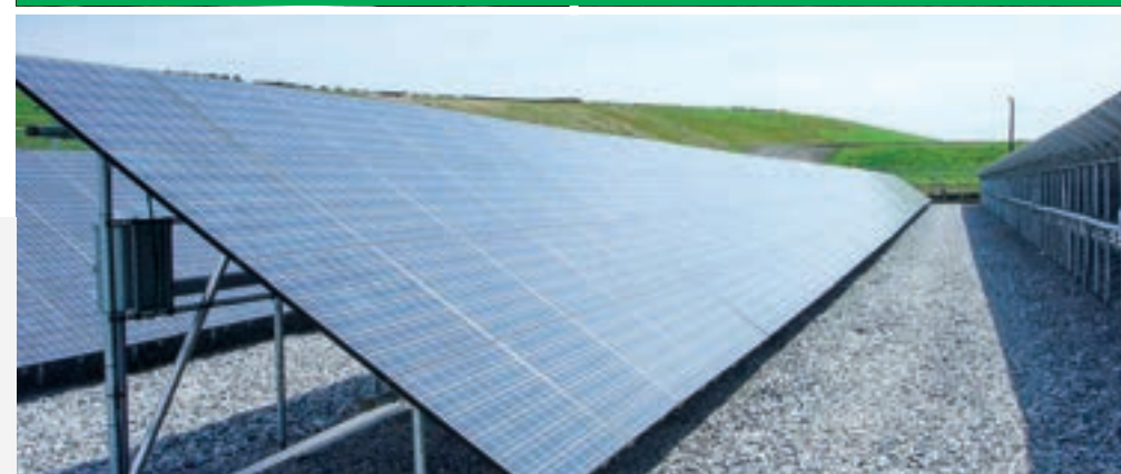
BEZ WYKOPÓW / BEZ BETONU
